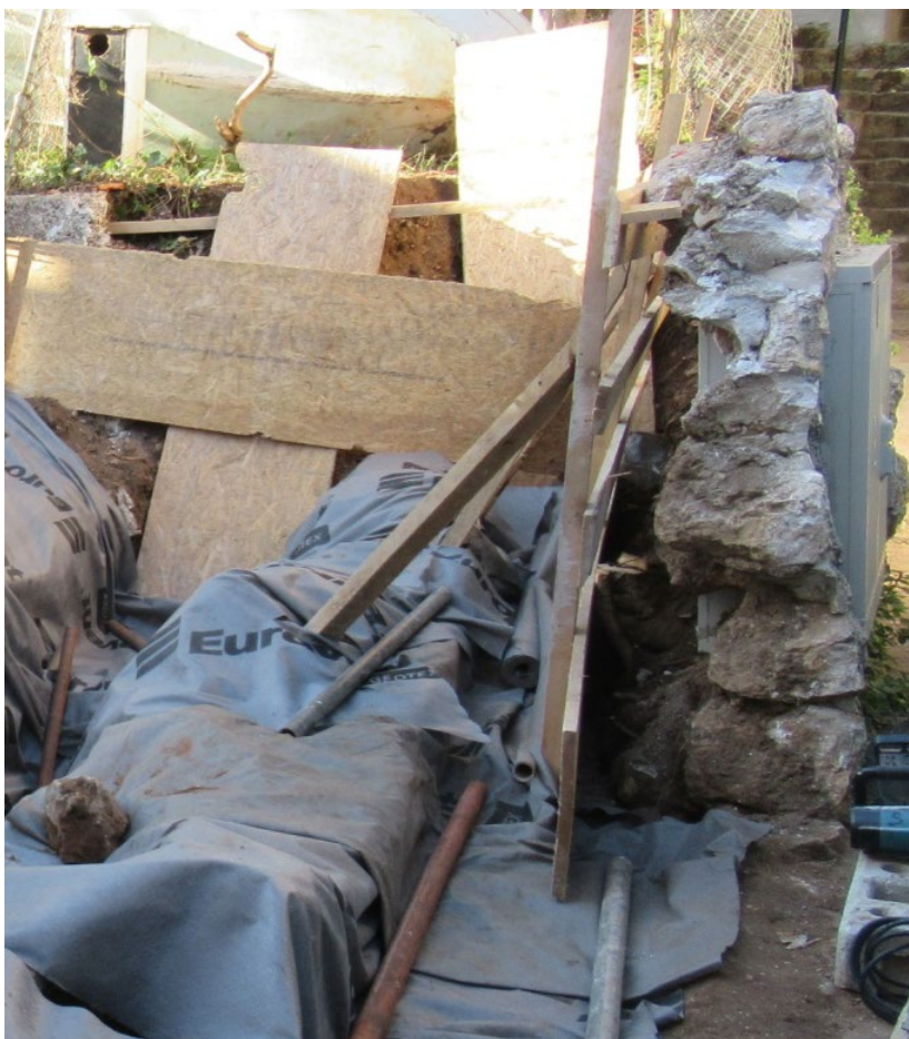
Geotekstilom zaštićeni nalazi i privremena zaštita "shozida" od urušavanja
